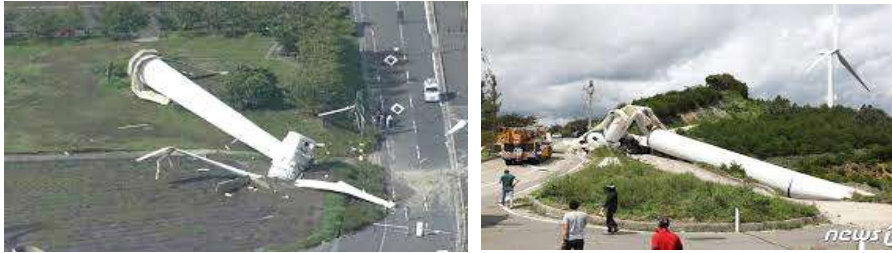
[그림 III-1] 낙뢰에 따른 풍력발전기 피해
