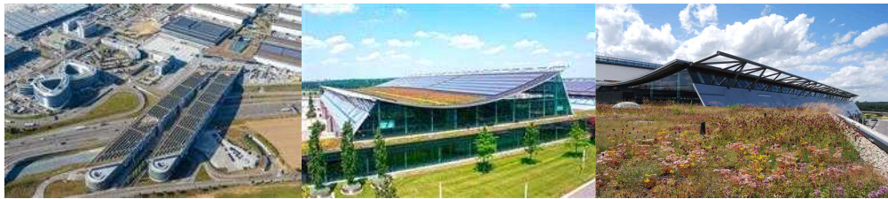
그림 60. Messe Stuttgart 와 보쉬 주차장에 설치된 태양광 녹색지붕의 모습
