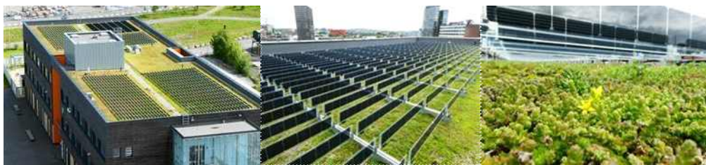
그림 61. Løren skole 지붕에 설치된 수직 양판형 태양광 모듈과 녹색지붕
